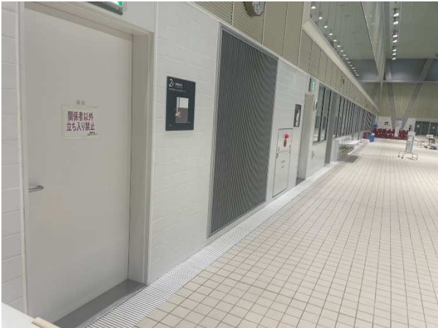
プールサイド出入口
